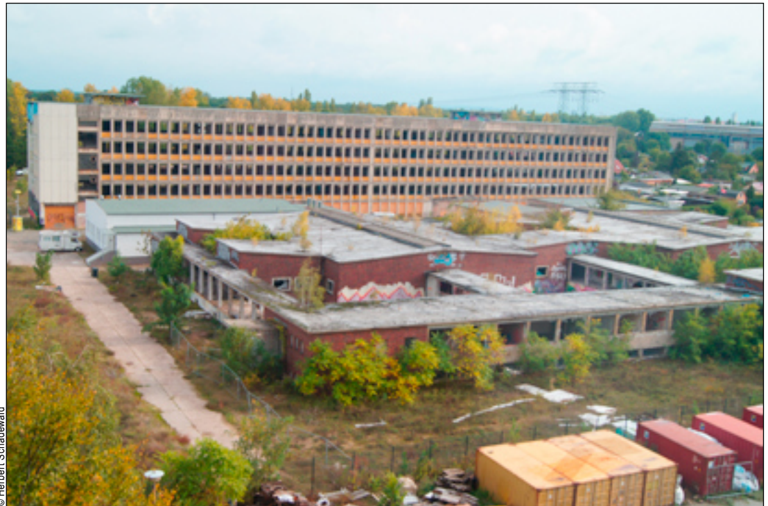
Auf dem DDR-Rundfunkgelände waren bis zum 31. Dezember 1991 sechs Sender beheimatet. Eines der ehemaligen Redaktionsgebäude des DDR-Rundfunks mit dem einstigen Sendestudiokomplex im Vordergrund.
